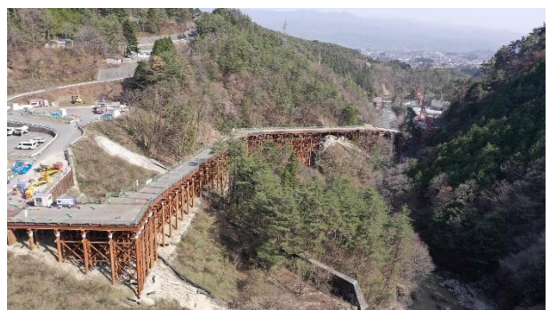
中央アルプストンネル松川工区（羽場方面より）
