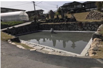
恒川史跡公園清水エリア第1期工事
