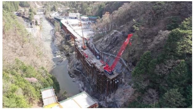
中央アルプストンネル松川工区（トンネル坑口）
