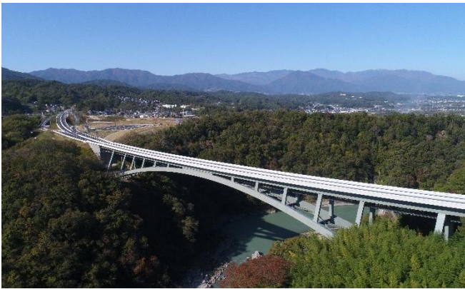
R1.11.17 三遠南信自動車飯橋道路2工区開通 天龍峡大橋（添架歩廊：そらさんぽ天龍峡）
